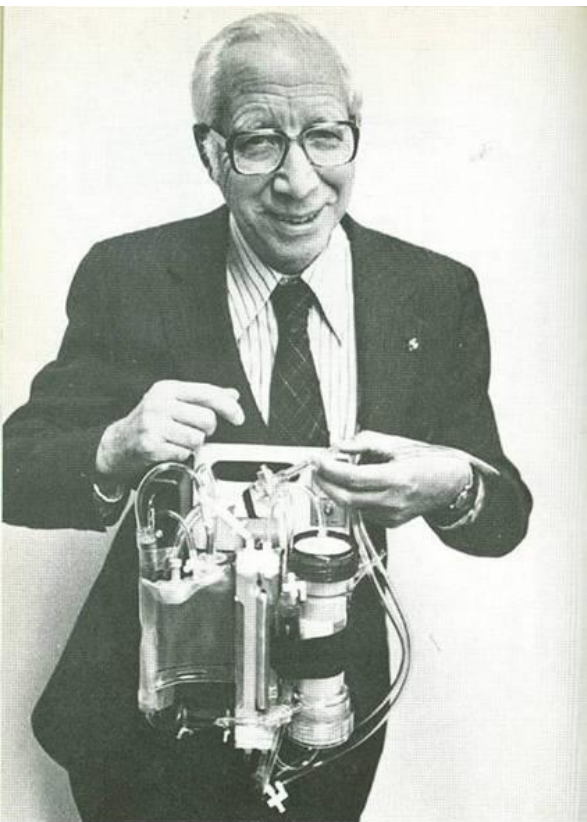
Fig. 6 W. J. Kolff met de draagbare nier, juli 1976. Het gewicht van de W.A.K. is 3 kg.
